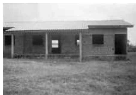
Logement du pasteur dont la construction est interrompue faute de moyens.
