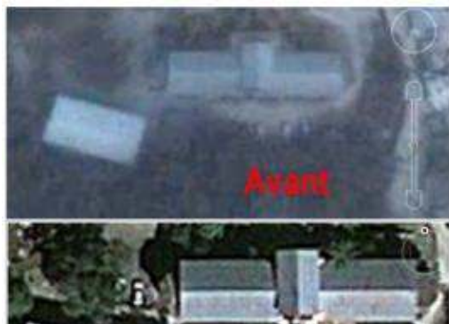
Photo aérienne de Google des 2 bâtiments principaux du STEP de l'UEBH Bolosse
